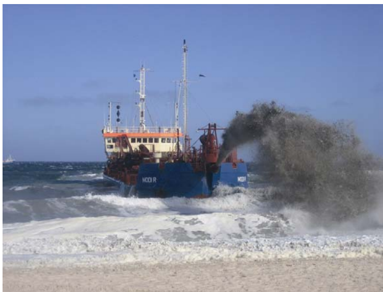
Sandfodring ved kysten. Skibet pumper sand ind mod kysten fra en dyse i stævnen
