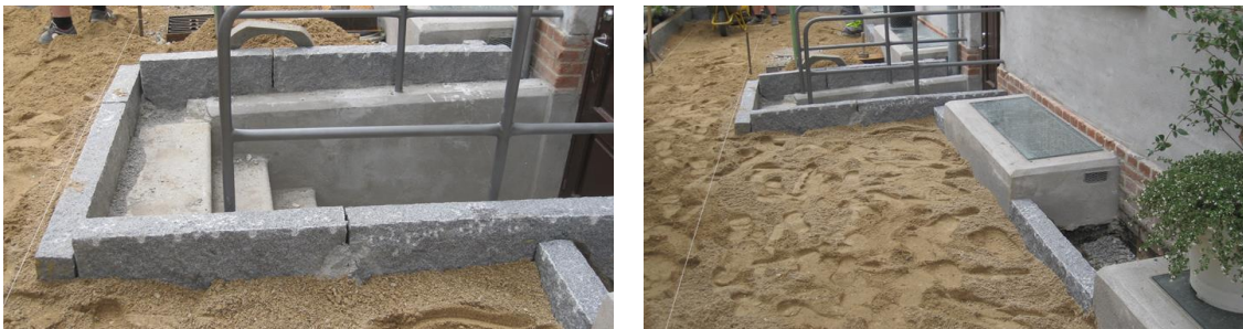
Figur 4.50 Skybrudssikring ved hævnning af kant omkring kældertrappen samt forhøjede og overdækkede lyskasser
