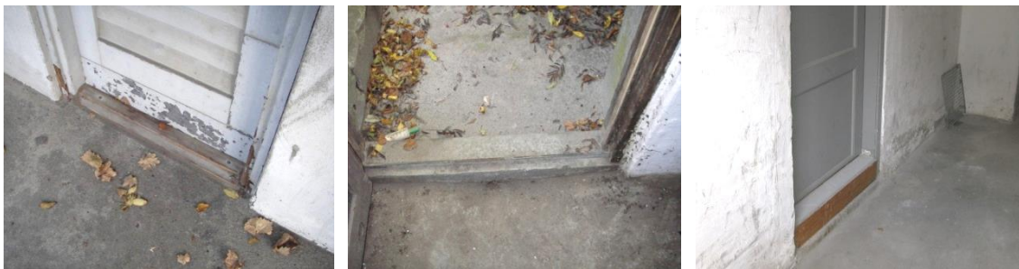
Figur 4.1 Eksempler på kant/dørtrin ind mod kælder
