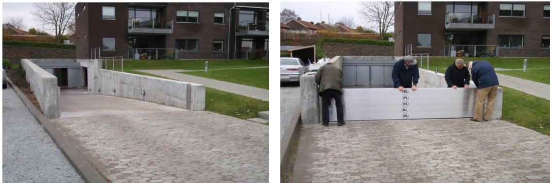
Figur 4.13 Skot, der kan monteres på garagedkørsel ved varsel om skybrud ( www.stormflodssikring.dk )
