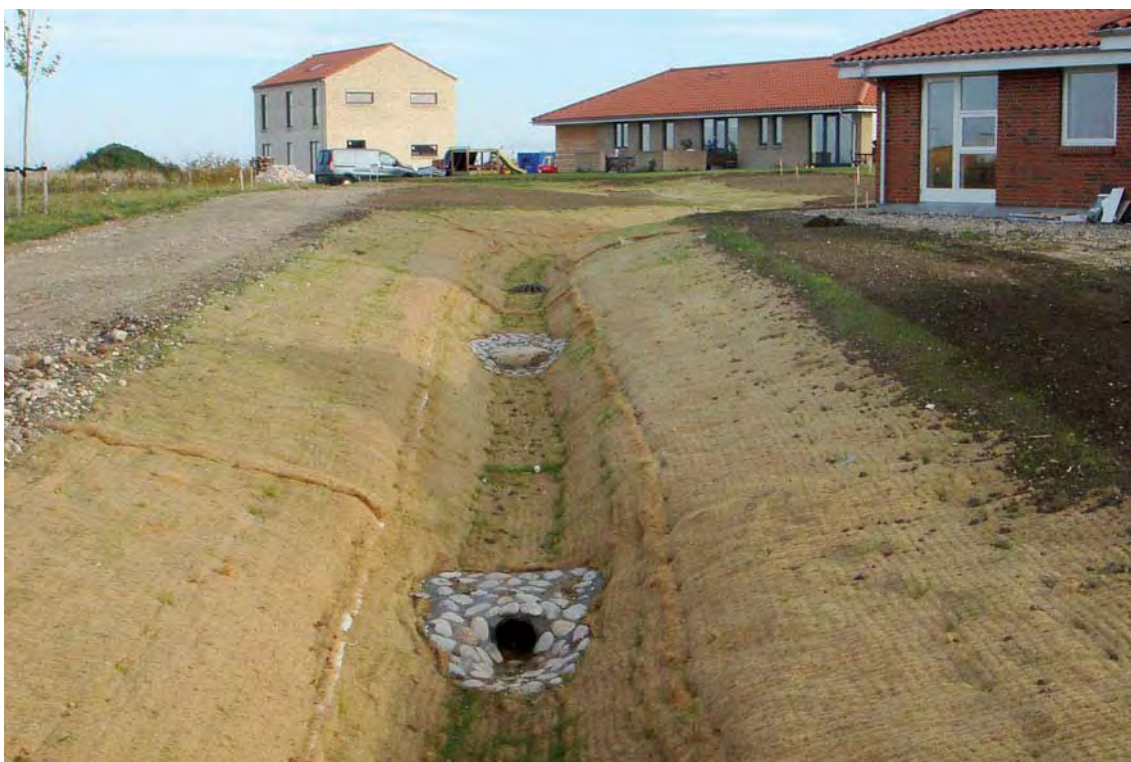
Grøft til regnvandsafledning ved Trekroner. Foto: Ole Fryd.
