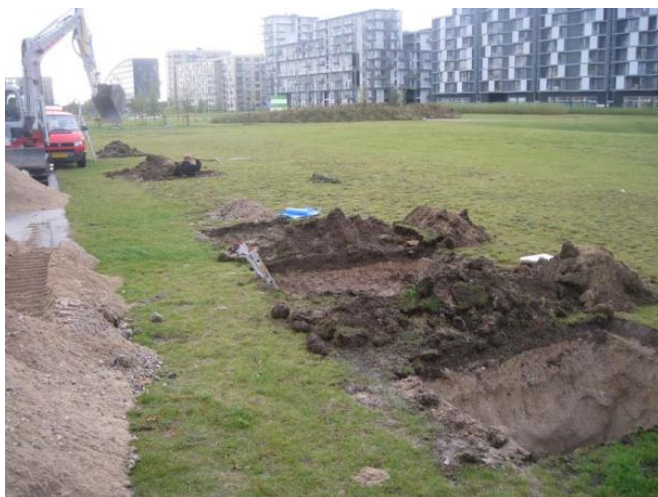
Figur 6 Opgravning af dobbeltporøst filter i Ørestaden (Hallig og Jensen, 2011)
