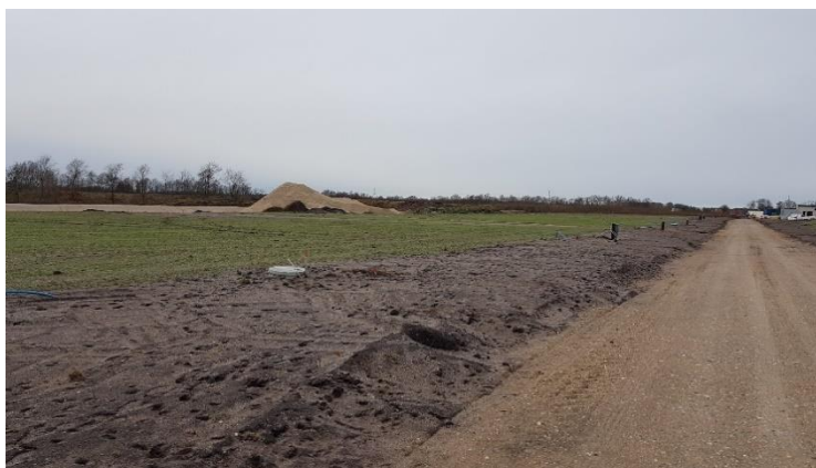
Foto fra tilsvarende byggemodning med hævet terræn i Sunds tæt på Aulum, januar 2019 – WSP
