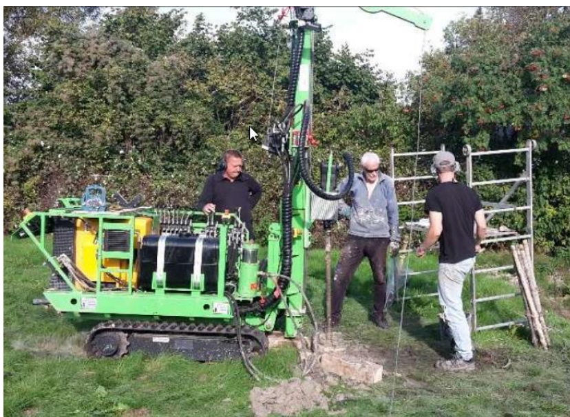
Etablering af pejleboring i en have
