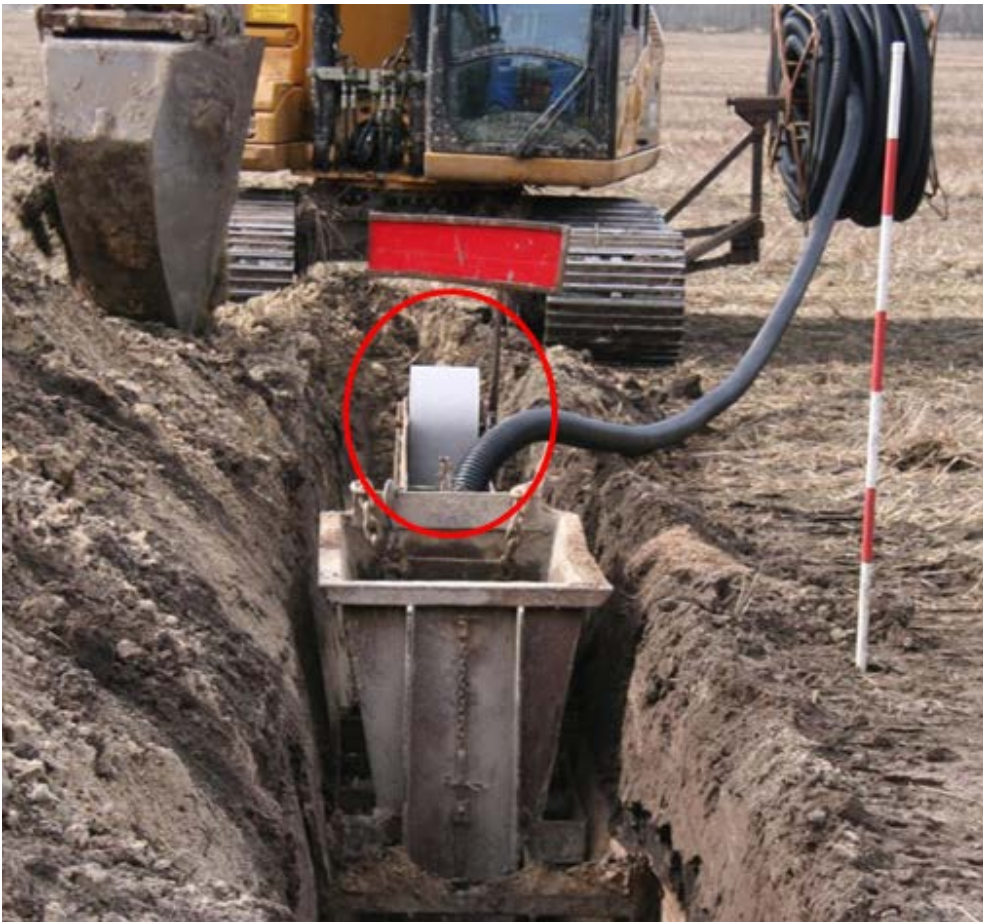
På billedet ses et eksempel på, at en strimmel af fiberdug lægges under drænrøret ved lægning. Foto: Janne Aalborg Nielsen, SEGES.
