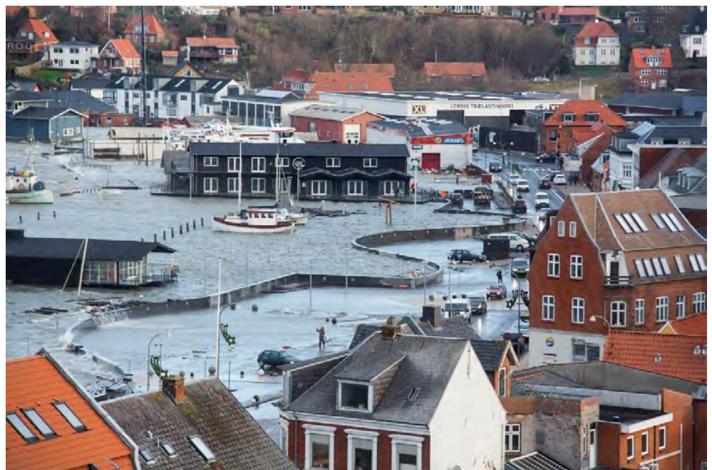
Figur 3-1 Stormflodssikring i Lemvig.
