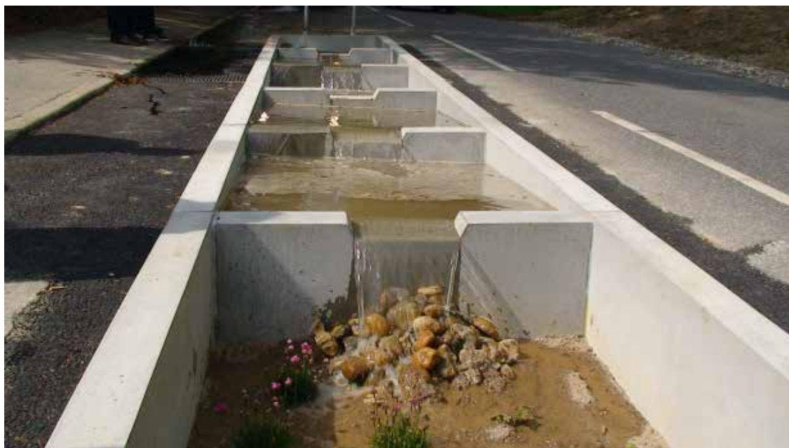
Figur 7b: Foto af anlægget skitseret i Figur 7b. Kilde: Nielsen og Winther, 2013.
