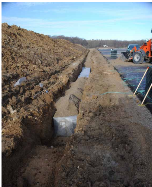
Figur 6b: Foto af anlægget skitseret i Figur 6a. Til venstre ses etableringen af faskine-elementet, bestående af regnvandskassetter omviklet af filterduk. Gruspude regulerer overkant til at flugte med terrænet. Til højre ses truget med de tværgående betonelementer. Rullegræs er ved at blive lagt ud. Kilde: Københavns Universitet, 2015.
