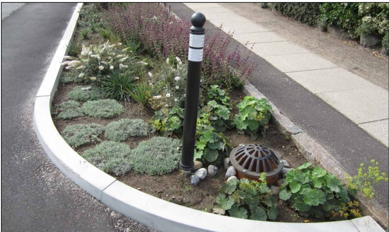
Figur 4b: Lindevang, der siden 2012 har været afvandet via vejbede. På Lindevang er mange af villaerne ligeledes afkoblet helt eller delvis. Fra LAR-anlæg på egen grund er der overløb til offentlig vej. En enkelt vejbrønd i vejens lavpunkt er ikke afblændet, men beregnet til afdræning til kloak i tilfælde af at vejbedene fejler. Foto: @Lene H. Poulsen.
