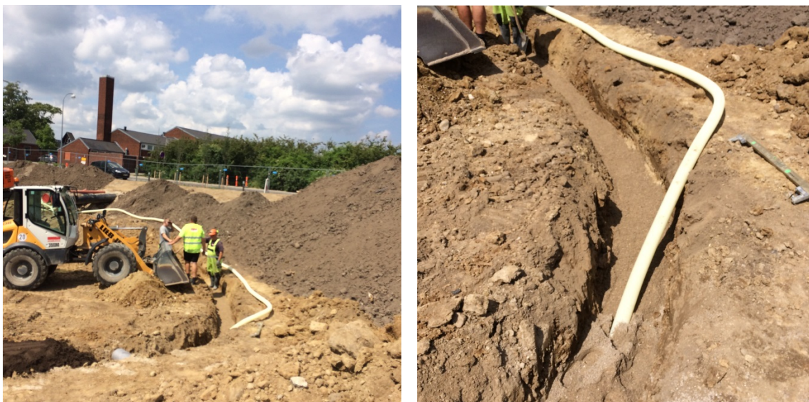
Figur 8b: Fotos fra anlæg af lavning med drænkasse vist i Figur 8a. Kilde: Gladsaxe Kommune.
