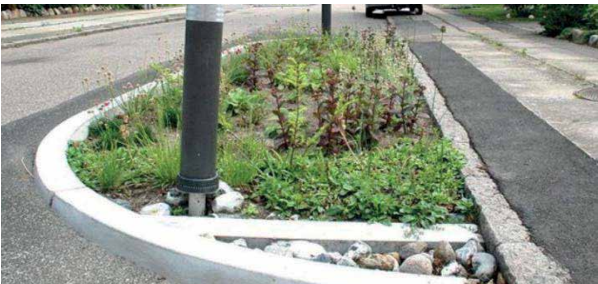
Figur 5b: Møllebakken, der siden 2012 har været afvandet med vejbede. En enkelt vejbrønd i vejens lavpunkt er ikke afblændet. Foto: Mulighedskatalog for grønne regnvandsløsninger, HOFOR ( https://klikovand.dk/wp-content/uploads/2016/04/HOFOR_mulighedskatalog_version-1A-juni-16.pdf ).
