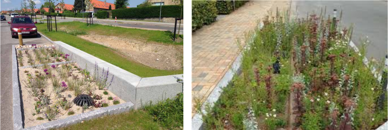
Figur 12: Til venstre: Vejbed anlagt med granitkantsten (Foto: Århus Vand). Til højre: Vejbed anlagt med fordelerrende i bedets længderetning (Foto: Bjørn et al., 2019).
