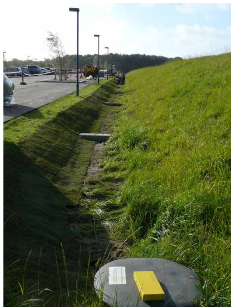
Figur 6b: Foto af anlægget skitseret i Figur 6a. Til venstre ses etableringen af faskine-elementet, bestående af regnvandskassetter omviklet af filterduk. Gruspude regulerer overkant til at flugte med terrænet. Til højre ses truget med de tværgående betonelementer. Rullegræs er ved at blive lagt ud. Kilde: Københavns Universitet, 2015.
