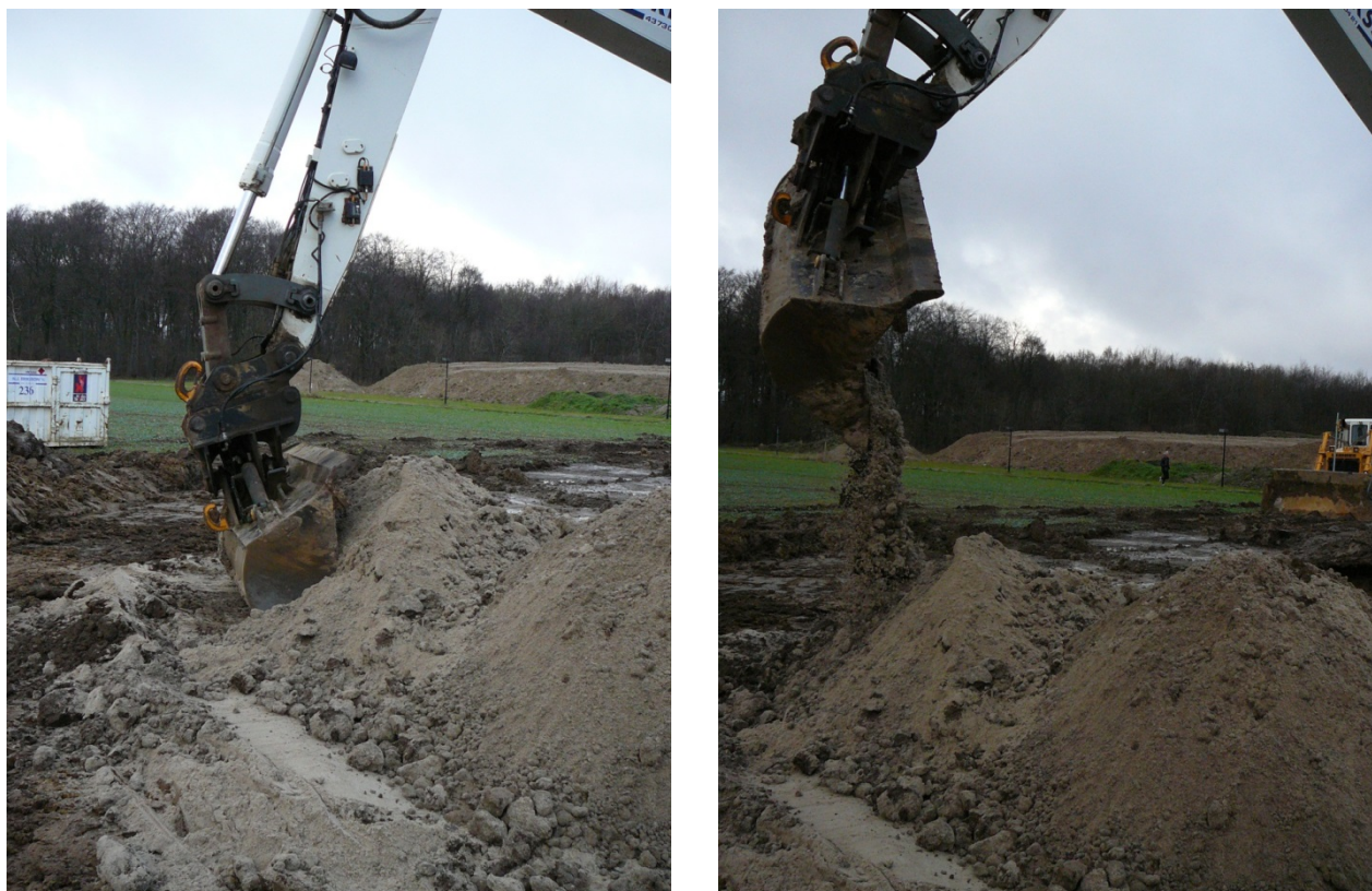
Figur 2: Fremstilling af filterjord på stedet. Oprindelig muldjord fra tidligere landbrugsareal opblandes med sand for at justere hydraulisk ledningsevne. Kilde: Københavns Universitet, 2015.
