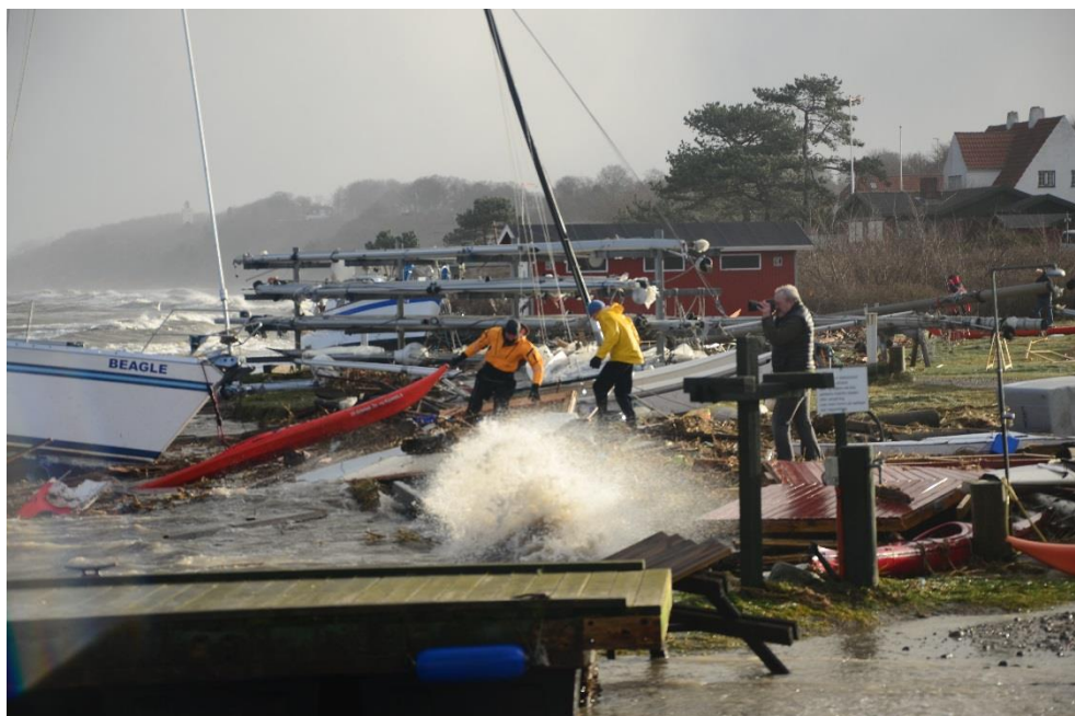
Figur 3-1 Skader ved Bodil stormen i Gilleleje Havn
