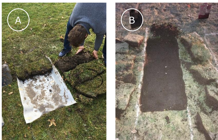
Figur 2. A: Udlægning af fiberdug under græstørv. B: Jorden under græstørv er stampet med en jordloppe
