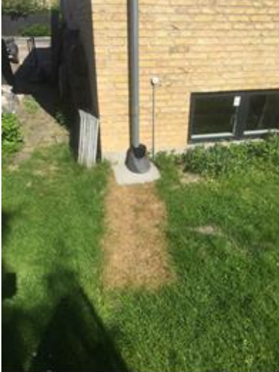
Figur 5.4. Eksempel på rende, hvor græsset er visnet
