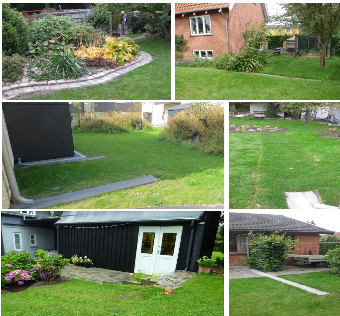
Figur 4.2. Forskellige eksempler på udformning af render, der leder vandet væk fra huset
