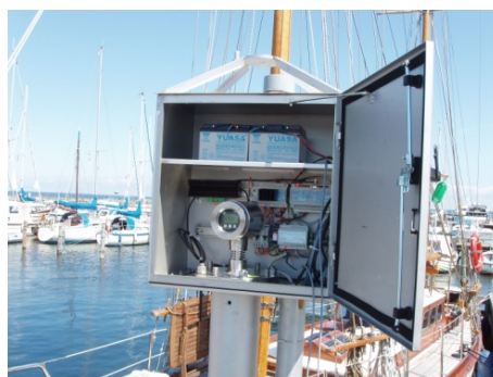
Figur 6: Elektroniskab – Radarmåler i Dragør (DMI)
